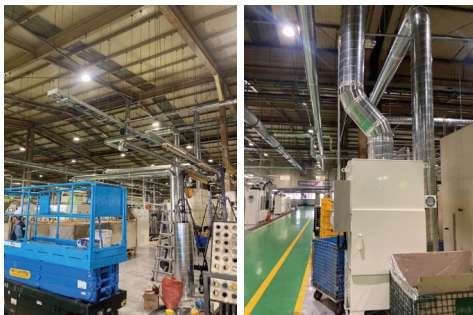
집진기 공사 진행
